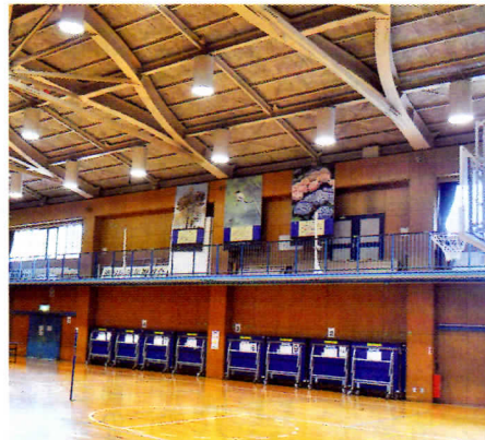
写真中央の壁沿いに室内機、ギャラリーの下部に吹き出し口を設ける※8月16日撮影
